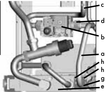
3/4" (d), момент натяжения составляет 35 Нм. Соединение газовой арматуры с нижней планкой (e) происходит теперь не посредством латунного фланца, а посредством имеющегося на стальной трубке крепежной пластинки (g), которая привинчена двумя винтами (h) к нижней планке. Новая и прежняя газовая арматуры не взаимозаменяемы, это означает, что заказные номера на прежний газовый тракт действуют, как и прежде.
