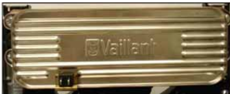
Вторичный теплообменник с NTC-датчиком (котлы серии plus)
