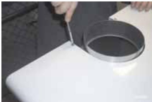
Рис. 3 - Выкрутите два винта - самореза 2, удерживающих крышку котла.
