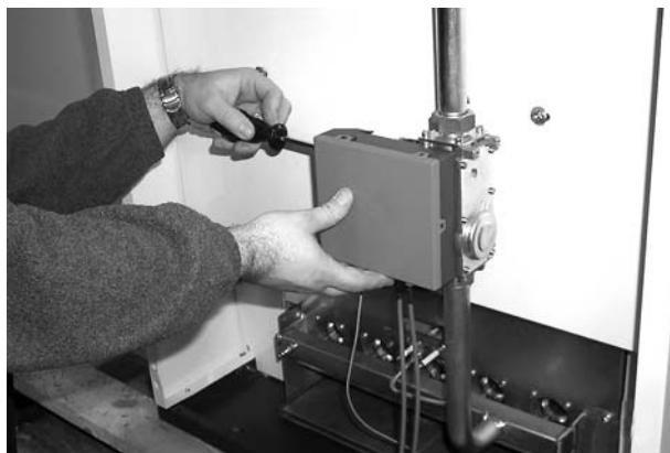
рис. 7 - Открутите два винта крепления блока управления
