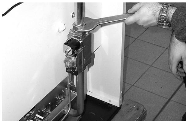
рис. 9 - Открутите гайку крепления газового клапана
